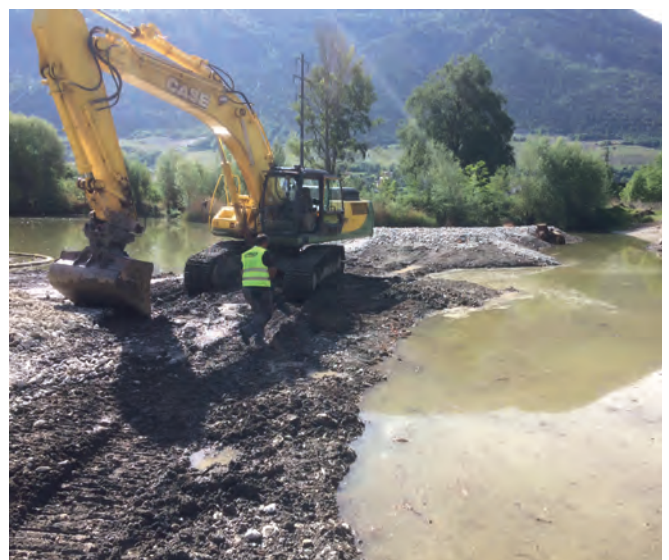
Figure 7 : Excavation du chenal de min 2m de profondeur entre les îlots et les rives [08.05.2018] Abbildung 7: Aushub der min. 2m tiefen Rinne zwischen den Inselchen und den Ufern [08.05.2018]
