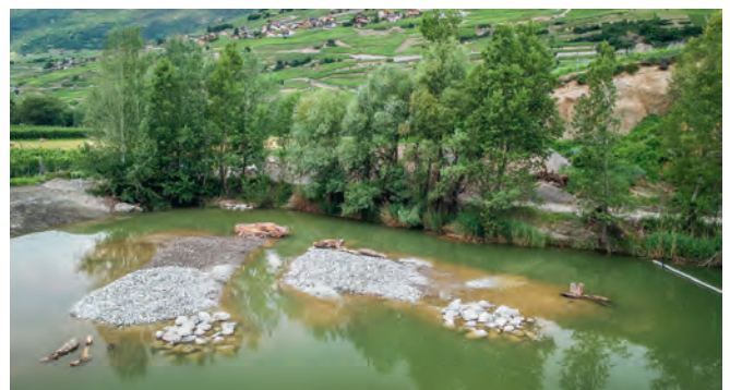
Figure 8 : Îlots au Nord-Ouest terminés avec vue sur les pierriers et les hauts fonds [31.05.2018]. Les bancs de galets sont hors des hautes eaux. Abbildung 8: Fertiggestellte Inselchen im Nordwesten mit Blick auf die Geröllhalden und Untiefen [31.05.2018]. Die Kieselsteinbänke liegen ausserhalb des Hochwassers.
