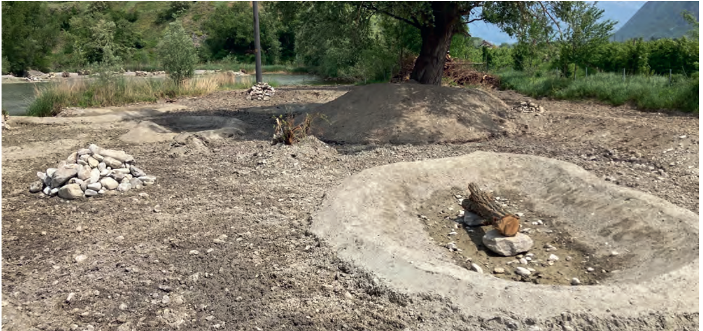
Figure 9: Phase 3, abgeschlossene Arbeiten am Südufer mit Schaffung von Untiefen, Wasserflächen, Geröllhalden und Totholzhaufen ausserhalb des Hochwassers [23.05.2022]
