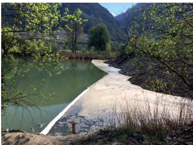
Figure 4 : Effet positif de rétention des particules fines du filet de protection [20.04.2018] Abbildung 4: Positiver Rückhalteeffekt des Schutznetzes für Feinpartikel [20.04.2018]
